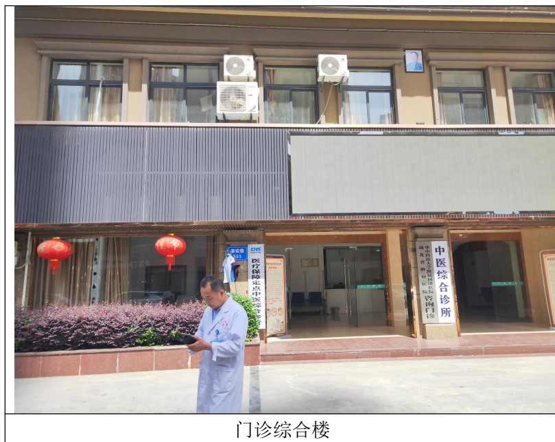
图 2-1 项目现场情况图片
